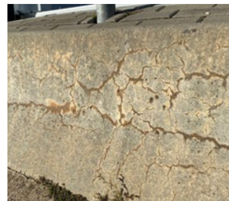
Reacción álcali-sílice como consecuencia de la lluvia ácida
