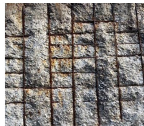
Ataque por carbonatación y corrosión de cloruros
